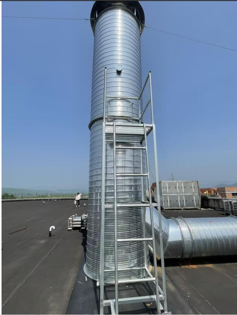
印刷车间有机废气处理设施出口监测点及采样平台
