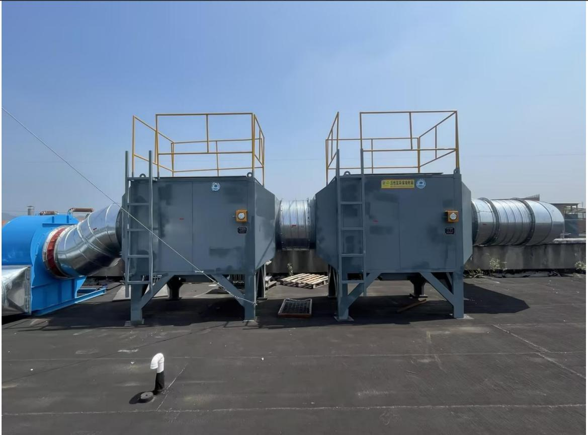
印刷车间有机废气并联两级活性炭（填装量 4t）
